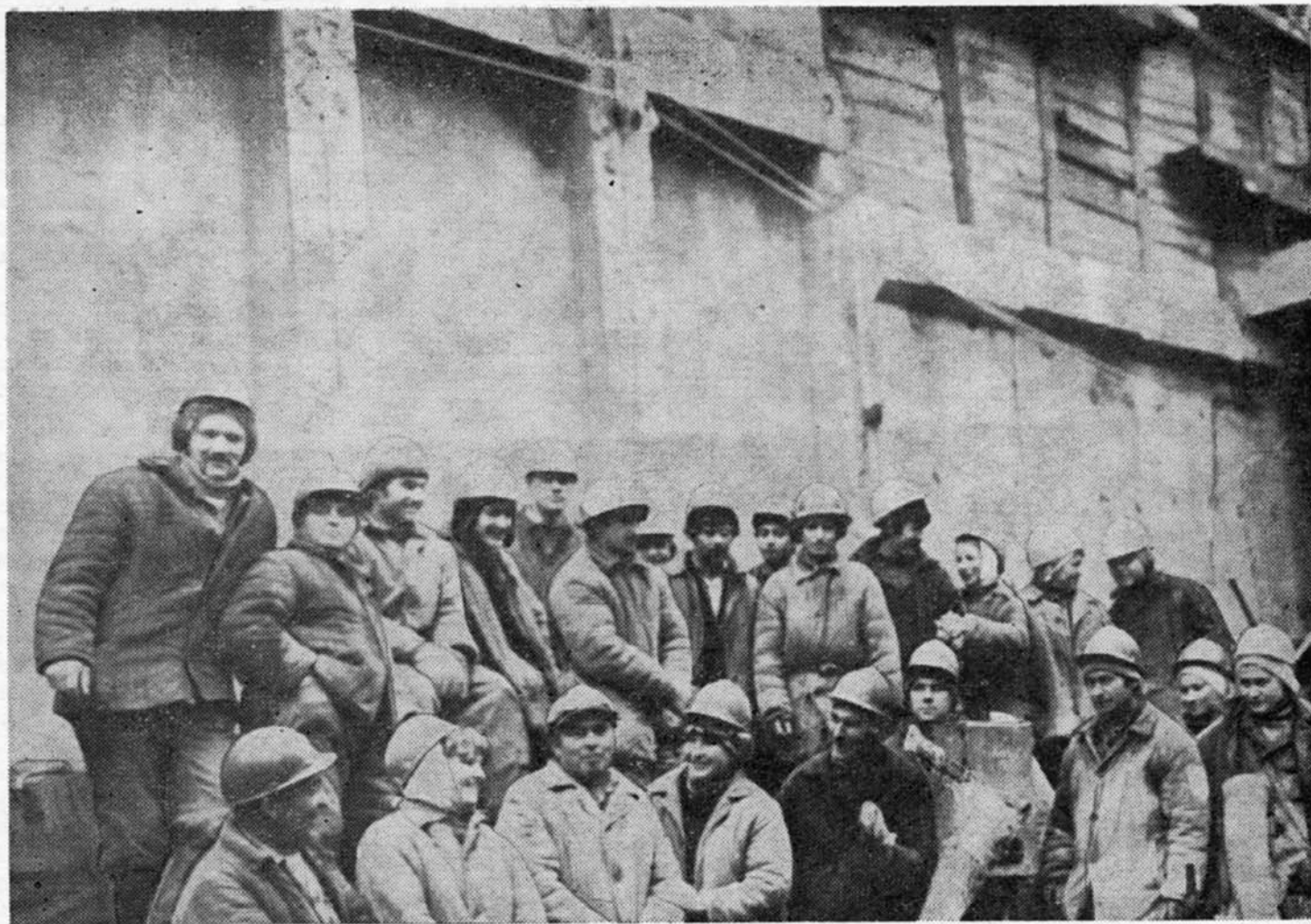
Комсомольско-молодежная комплексная бригада А. Акимова (СМУ № 3 Мосметростроя) забетонировала свод станции «Южная» менее чем за два месяца. Работы вели по скользящему графику с применением инвентарной передвижной металлической опалубки стен и свода.
