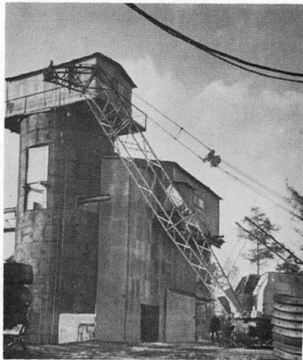
Горный комплекс на продлеваемом Замоскворецком радиусе (СМУ № 10 Мосметростроя).
