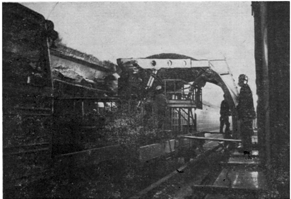
Демонтаж обделки действующего перегонного тоннеля с помощью УРО-1.
