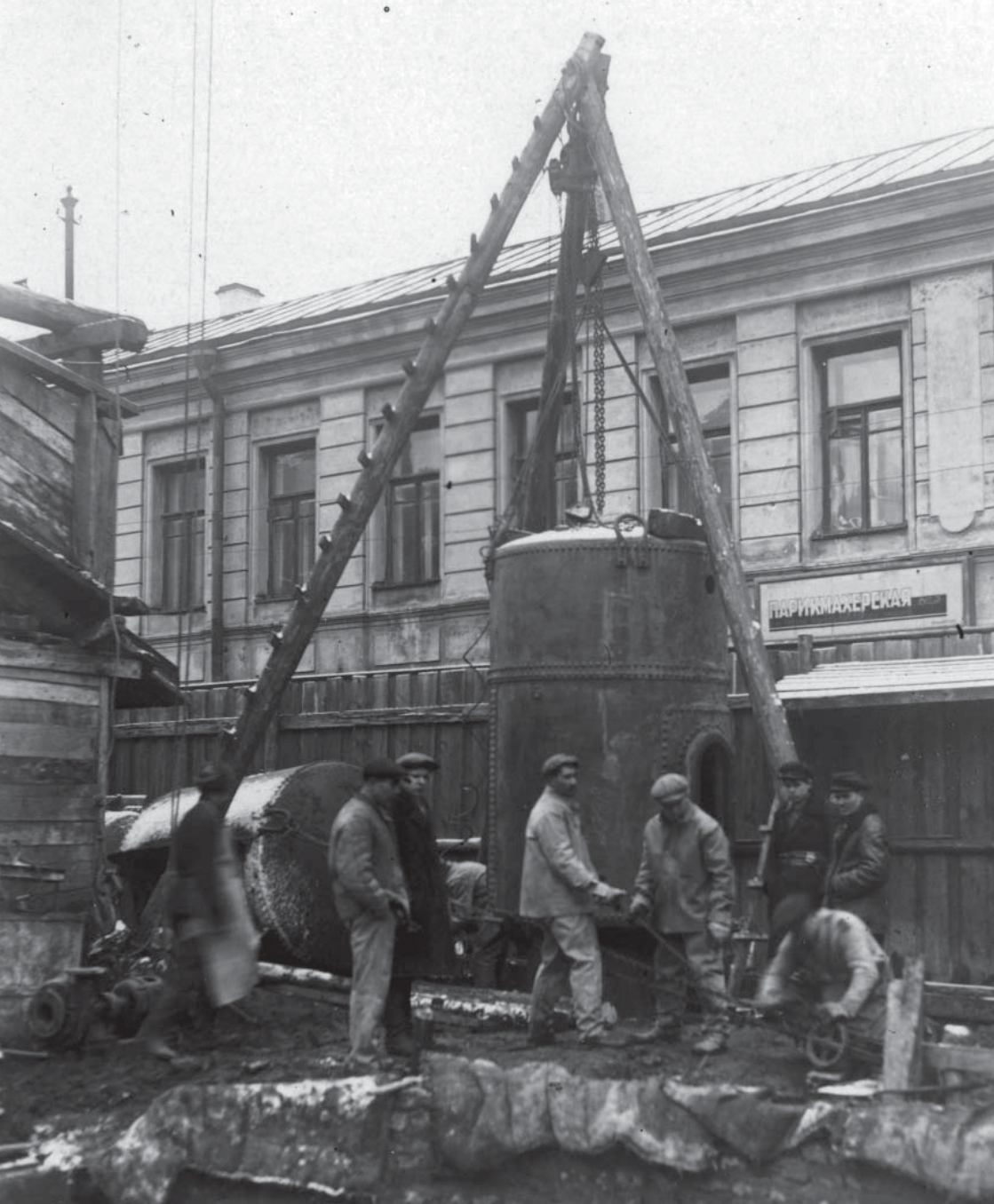
Монтаж кессонных аппаратов на строительстве первой очереди в 1933 году.
