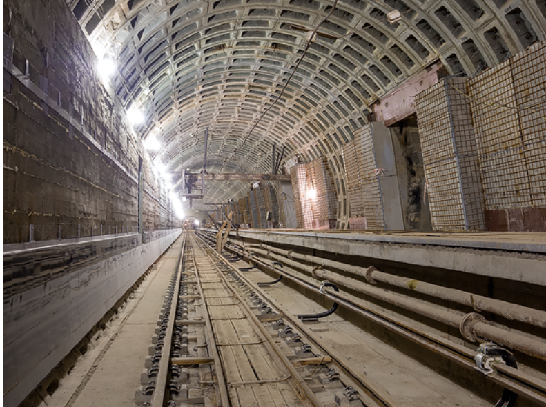
Сооружение станции «Проспект Славы» в Санкт-Петербурге. Фото сделано в ноябре 2017 года. Станция до сих пор не открыта
