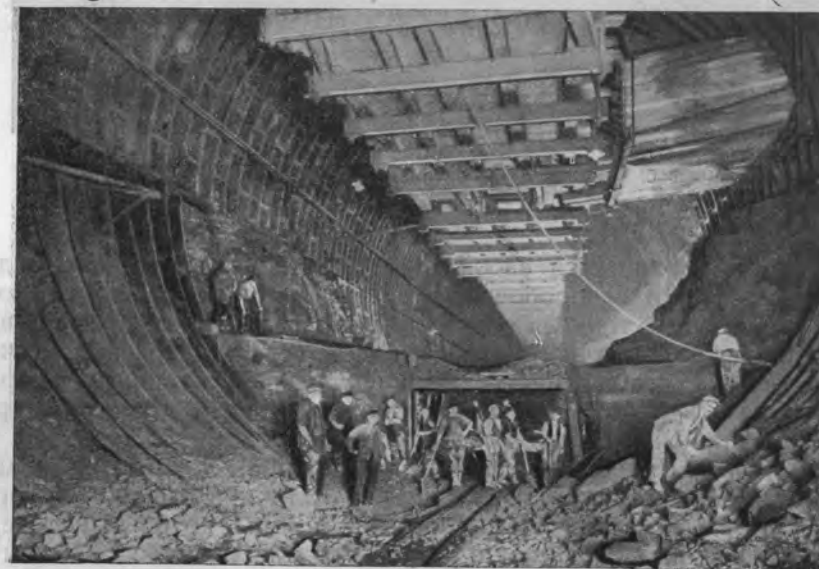
Рис. 342. Производство работ по обделке профиля ниже горизонтального диаметра в 13,41 м.
