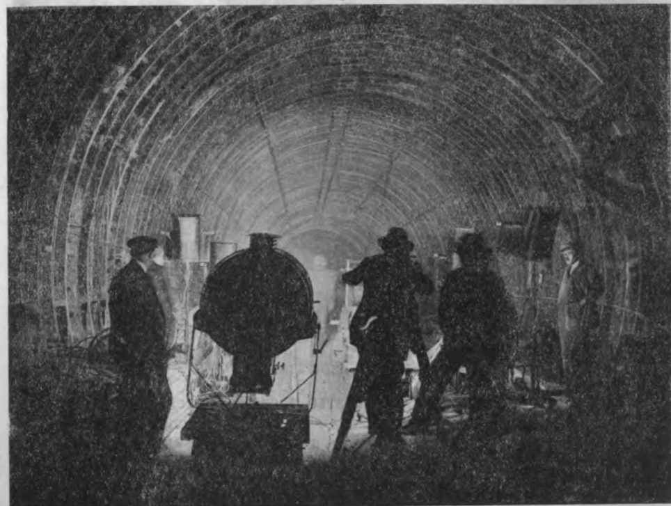
Рис. 25. Работы по разбивке оси тоннеля. Освещение прожекторами.
