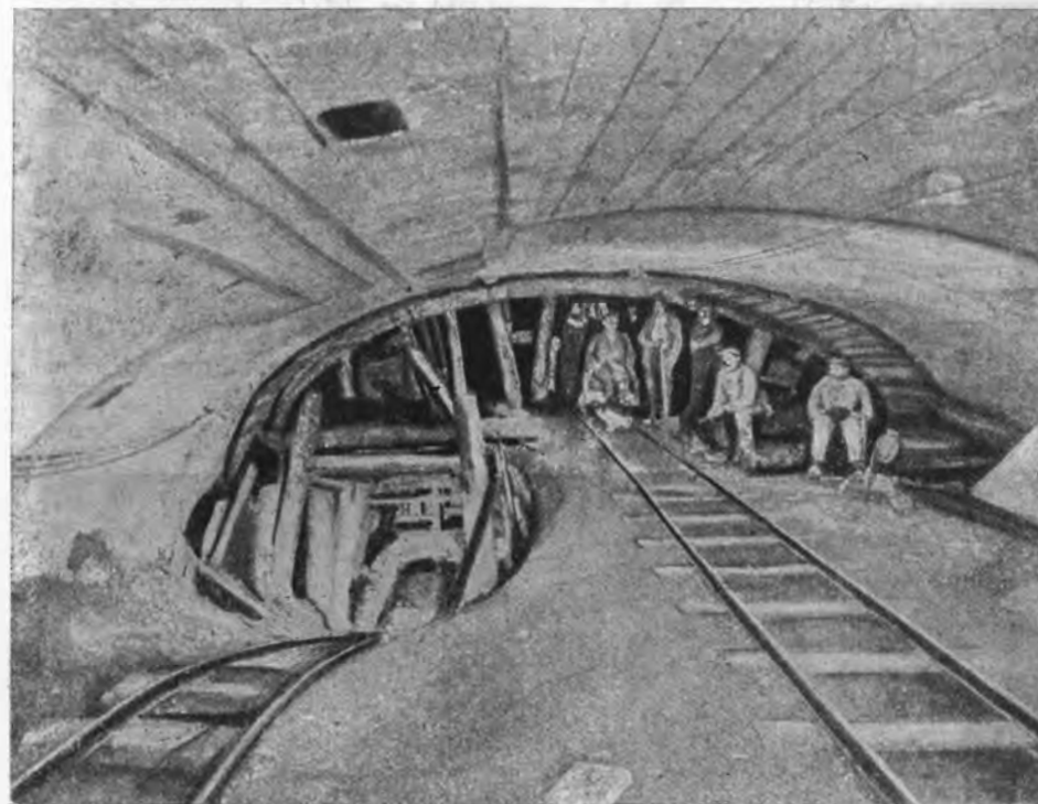
Рис. 125. Производство работ по сооружению тоннеля под Большими Бульварам в Париже. Спуск в нижний горизонт бремсбергом.
