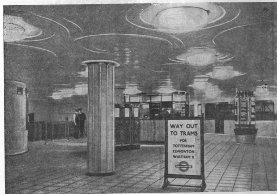
Рис. 84. Общий вид подземного вестибюля станции „Манор Хауз“
